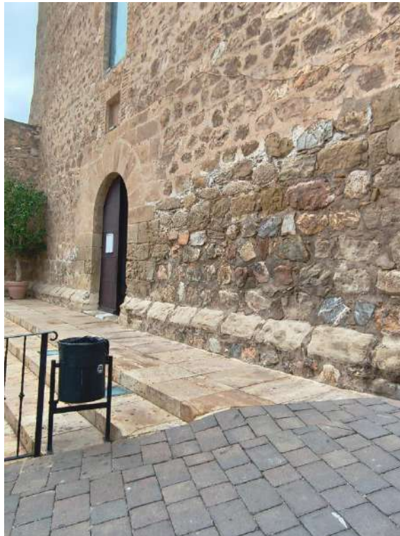
Pasillo peatonal de acceso a la iglesia.
