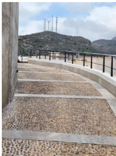
Rampa empedrada que da acceso al Mirador del Castillo.
